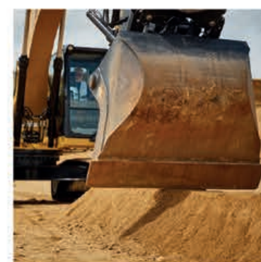
Pásovým rýpadlem se rovnal písčítý násep za pomoci 2D nivelace.
